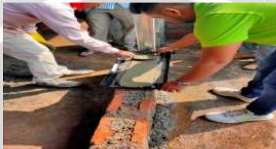
Fig.4.2.2. Apply Layer of Mortar
