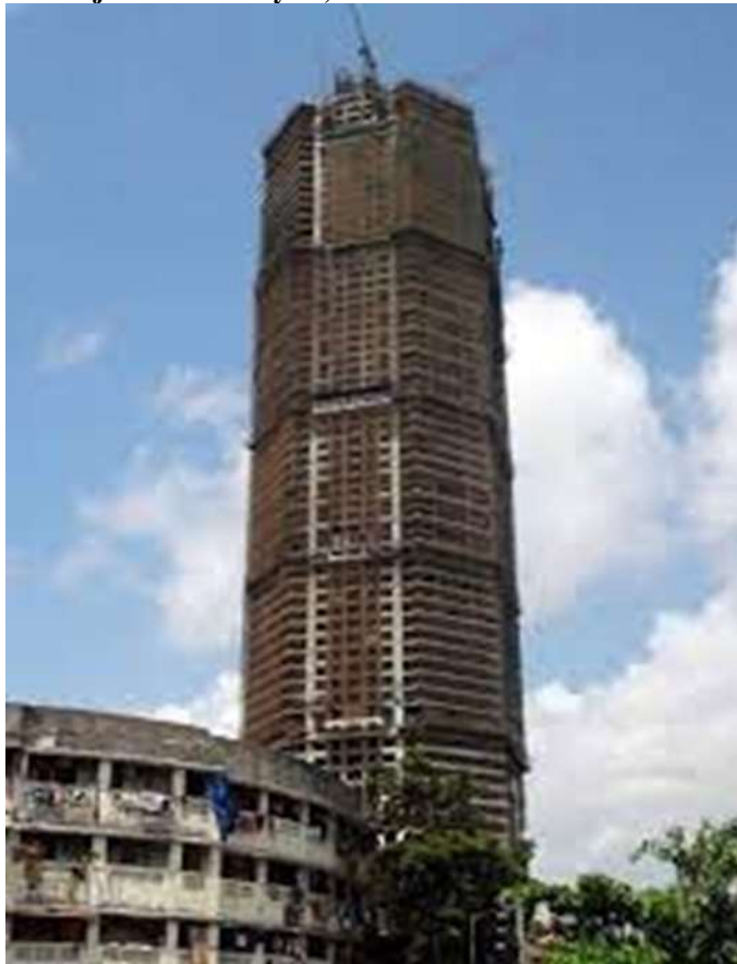
Figure 34 – Image of construction of palais royale Mumbai (Abdellatif & Abdellatif, 2020)
