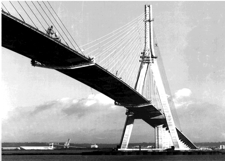
Fig. 8. Normandie Bridge pylon.
